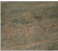
El agrietamiento por retracción plástica ocurre en cualquier superficie que ha sido acabada. Si el hormigón no se ha endurecido, el platachado usualmente cierra estas grietas.
