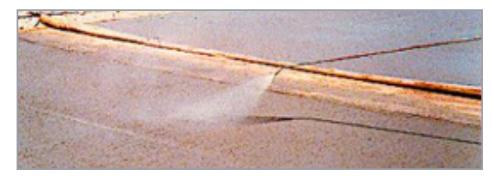
La aplicación de la membrana debe ser uniforme y suficiente para formar la película protectora.
