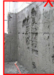
Desmolde de hormigón retardado
