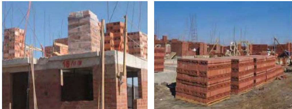
FIGURA 6.8 ALMACENAMIENTO DE LADRILLOS
