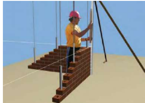
FIGURA 6.14 DETALLE TUBOS DE PVC EN TENSORES, REGLA CON ESCANTILLÓN Y LIENZA
