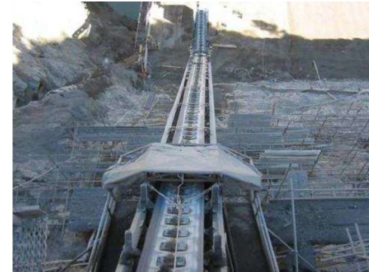
FIGURA 3.18 CINTA TRANSPORTADORA CON RESALTES
